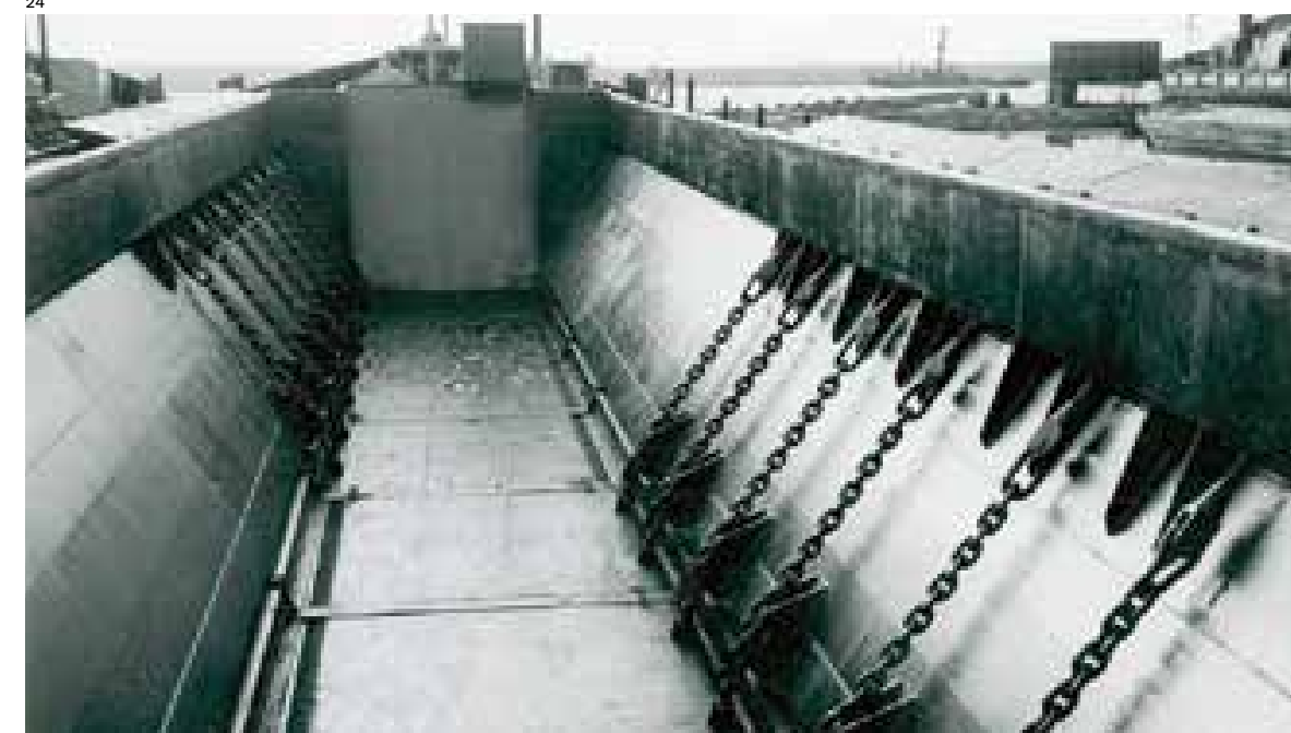
23 Tekening van een zelfleegzuigende hopperzuiger in een reclameboekje van L. Smit & Zoon uit ca. 1910. Het bijschrift luidt: "Voor het ledigzuigen is boven elke der beide kleppenrijen, die dienen om te lossen door in diep water te kleppen, een dubbele rij kleinere kleppen aangebracht. Hierdoor ontstaan dus twee kleppenkanalen, die elk aan de voorzijde door middel van een schuif in het voorste bun-schot met het buitenwater in directe verbinding kunnen worden gebracht. Met behulp dier twee schuiven kan de watertoevoer in die kanalen worden geregeld. De achterzijden dier kanalen staan weer in directe verbinding met de zandpomp en ook daar zijn schuiven aangebracht, zoodat elk kanaal meer of minder van de pomp kan worden afgesloten."
