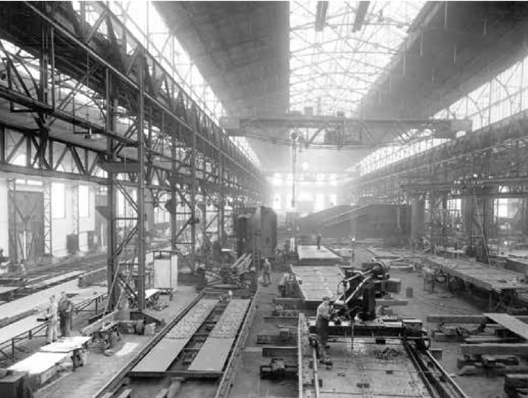
3 Bij Gusto in Schiedam werd in 1937 de brug over de Oude Maas te Dordrecht gebouwd.
