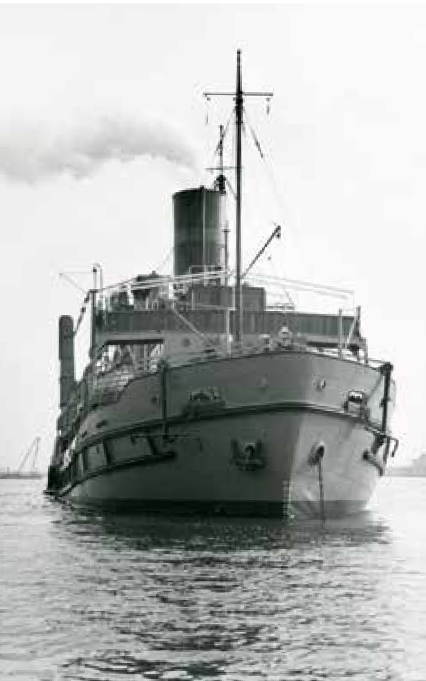
42 Voor Machinoimport uit Moskou bouwde J. & K. Smit in 1939 de zelfvarende stoombaggermolen Swirj.
