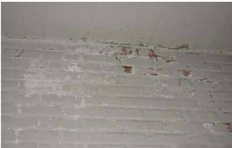
Doorslaand of opstijgend vocht kan leiden tot barsten in het metselwerk, voegen die worden uitgeduwd of schimmel.
